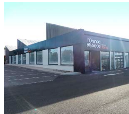
Lieu : Perpignan Équipements installés : VRF, Gainables
