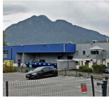
Lieu : Marnaz Équipements installés : VRF, Gainables, Centralisée
